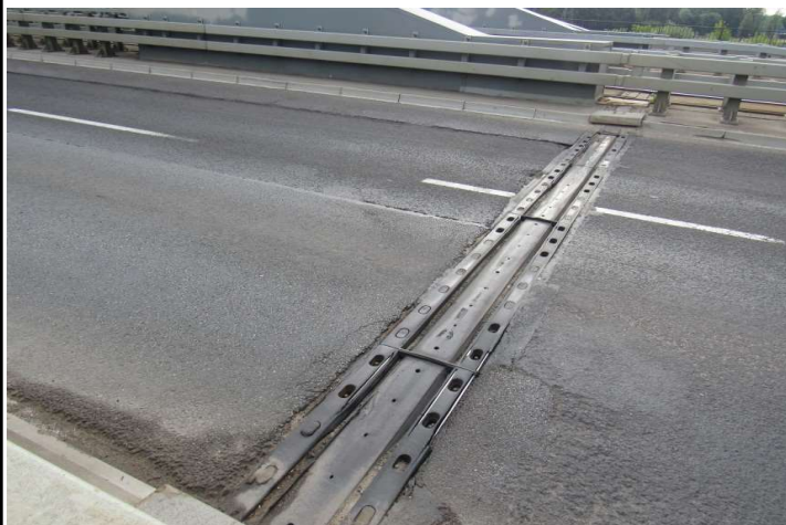
FOT. 3.2. WIDOK DYLATACJI CHODNIKA OD STRONY POŁUDNIOWEJ
