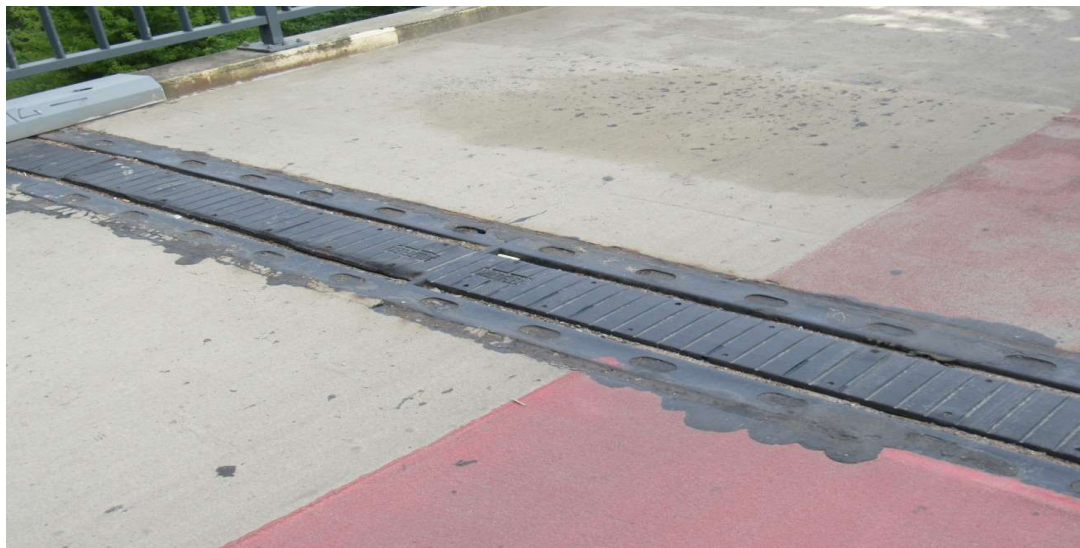
FOT. 3.3. WIDOK DYLATACJI JEZDNI OD STRONY PÓŁNOCNEJ
