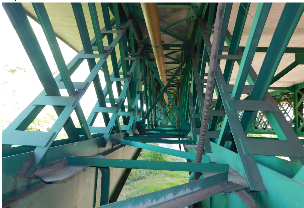
FOT. 13.3. WIDOK KONSTRUKCJI STAŁOWEJ PRZĘSŁA KRATOWEGO
