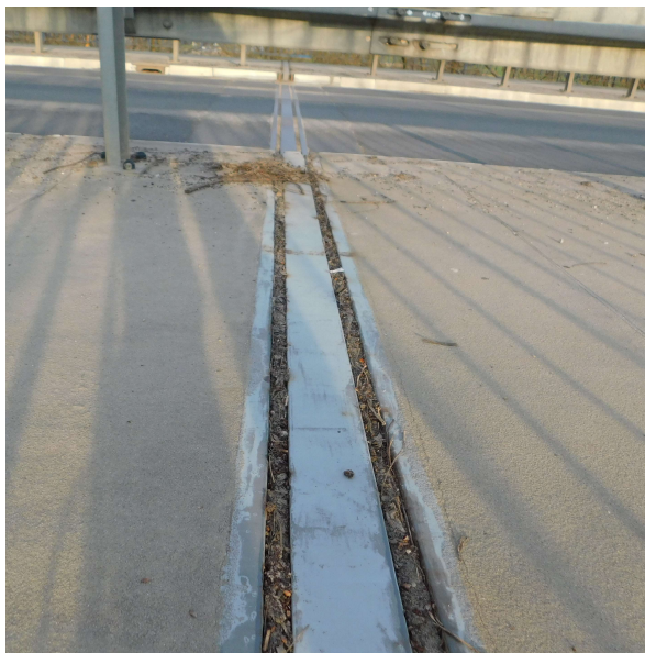
FOT. 3.2. WIDOK WIDOK DYLATACJI PODPORY NR 9 PRZYCZÓŁKA OD STRONY POŁUDNIOWEJ
