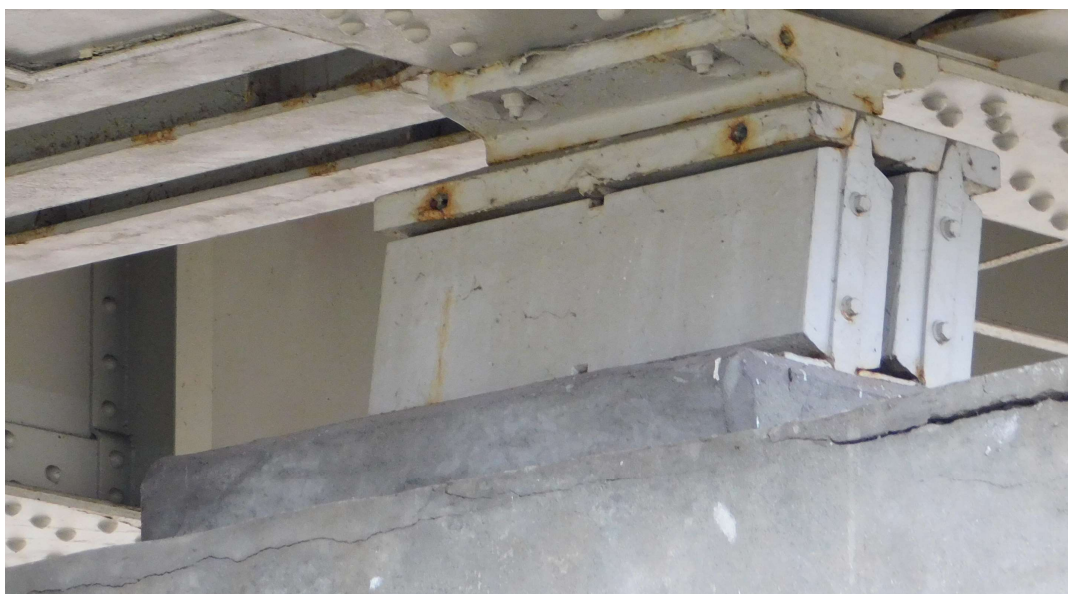
FOT. 5.2. WIDOK ŁOŻYSKA PODPORY NR 2 - FILARA OD STRONY ZACHODNIEJ - zanieczyszczenia, korozja
