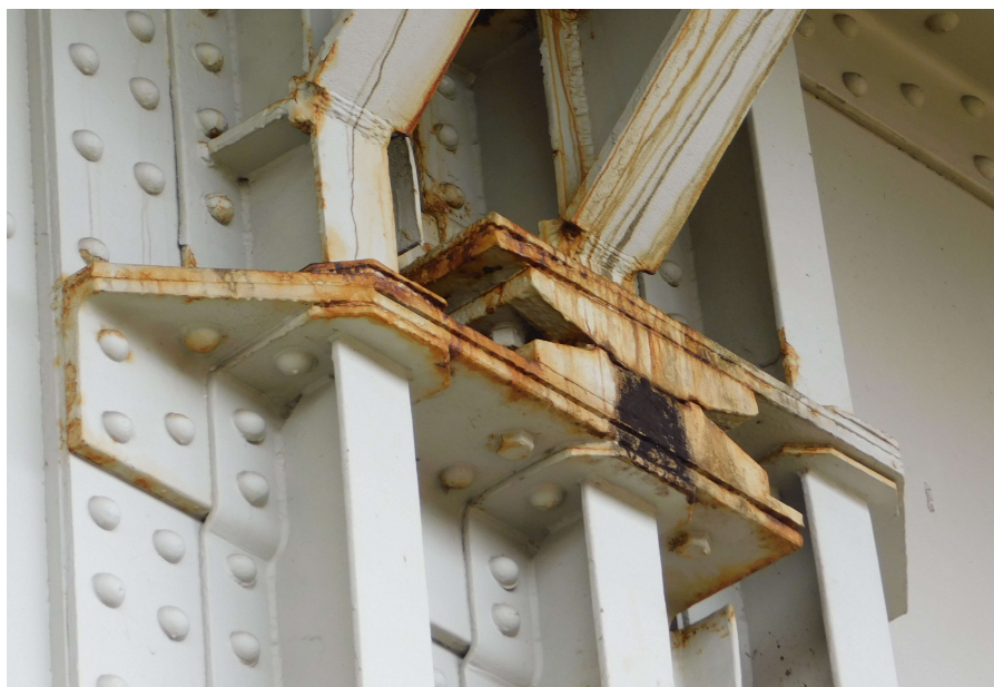
FOT. 5.2. WIDOK ŁOŻYSKA PODPORY NR 2 - FILARA OD STRONY ZACHODNIEJ - zanieczyszczenia, korozja
