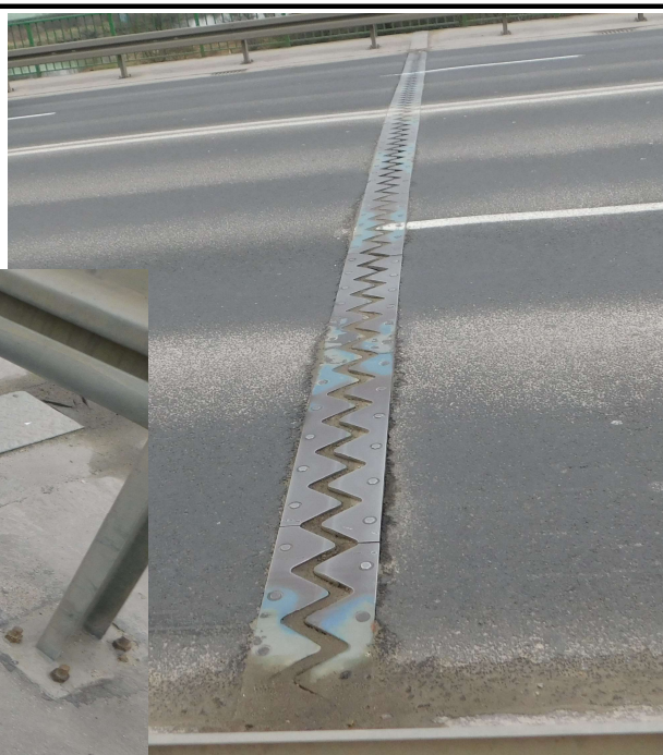
FOT. 1.3. WIDOK DYLATACJI PODPORY NR 2 - FILARA OD STRONY ZACHODNIEJ
