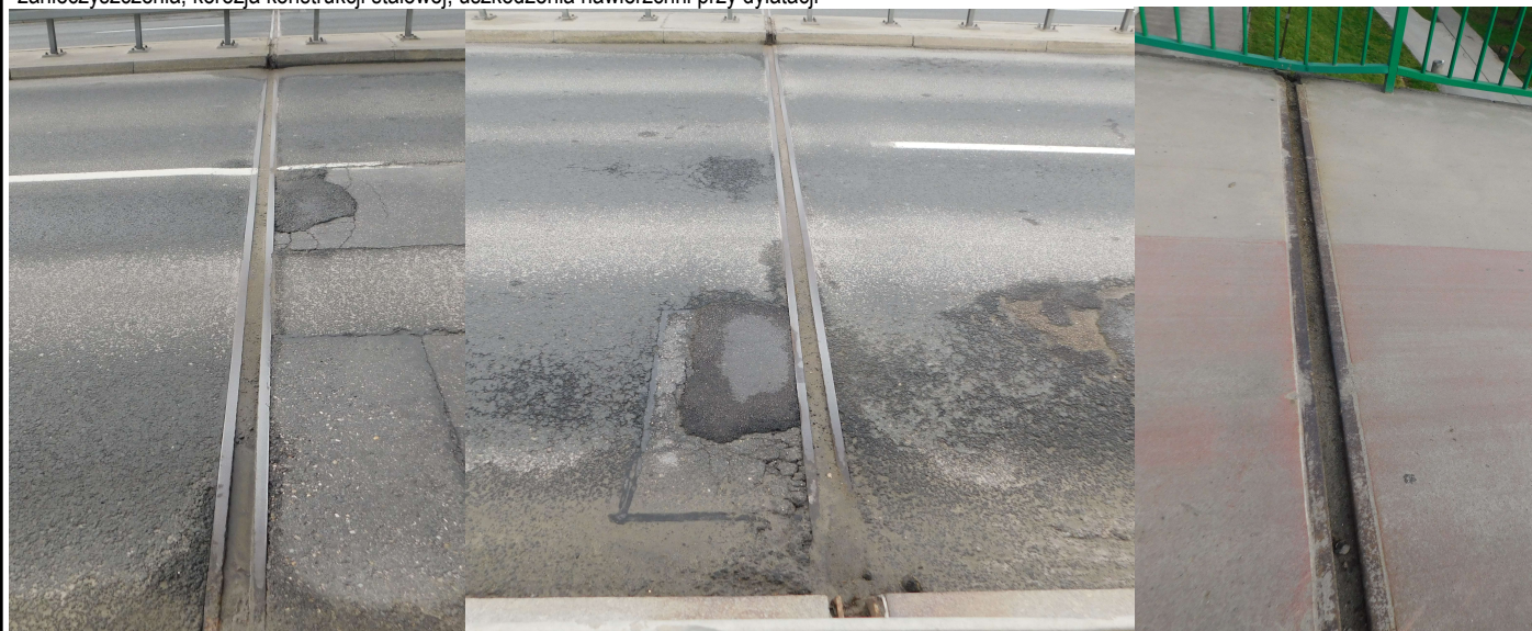
FOT. 1.3. WIDOK DYLATACJI PODPORY NR 1 PRZYCZÓŁKA OD STRONY POŁUDNIOWEJ - korozja, uszkodzenia kon. stalowej dylatacji - spękania, ubytki naw. kapy
