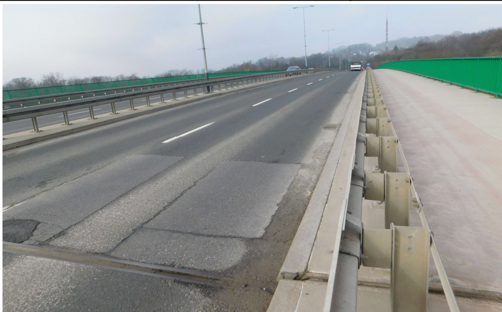
FOT. 1.2. WIDOK DYLATACJI PODPORY NR 1 - PRZYCZÓŁKA OD STRONY POŁUDNIOWEJ - zanieczyszczenia, korozja konstrukcji stalowej; uszkodzenia nawierzchni przy dylatacji
