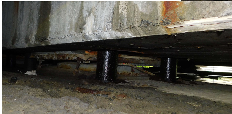
FOT. 11.2. WIDOK SKRZYŃKI PRZYCZÓŁKA - PODPORY NR 2 - ŁOŻYSK
