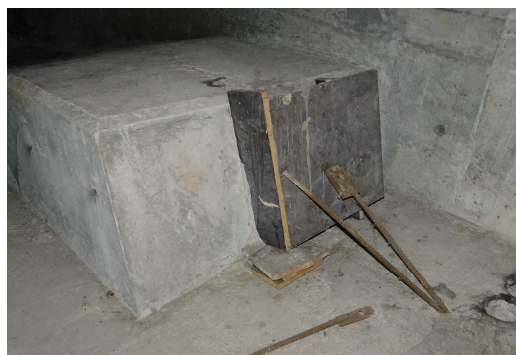
FOT. 10.2 WIDOK SKRZYNKI PRZYZCÓŁKA PODPORY NR 2
